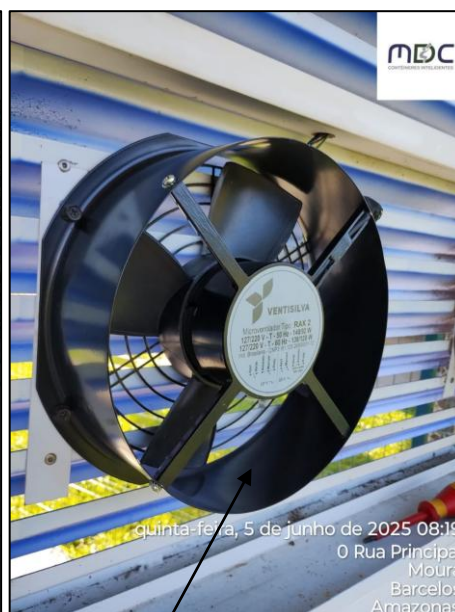
Eletro ventilador novo
